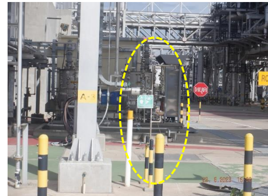
รูปที่ 2-60 ผักบัวอาบน้ำ ล้างตาฉุกเฉิน
