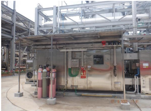
รูปที่ 2-32 การติดตั้งระบบตรวจวัดอากาศเสียแบบต่อเนื่อง (CEMS) ที่ปล่องระบายอากาศของ HRSG
